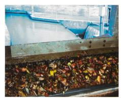
Bild 9. Beim Einlaufwerk zum Felsenbach-Kleinwasserkraftwerk hebt die automatische Reinigungseinrichtung Schwemmmaterial vom Rechen.
