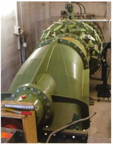
Bild 6. Beim ersten, neu erstellten Kraftwerk am Mühlbach versorgt ein 200 m langes Druckrohr die Rohrturbine mit einer Wassermenge von 1,8 m<sup>3</sup>/s. Damit werden jährlich rund 550000 kWh Strom erzeugt.
