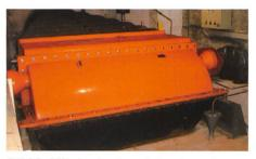
Bild 8. Mit der horizontal gelagerten Schaufelrad-Turbine wird in der «alten Säge» eine Wassermenge von ca. 1,2 m<sup>3</sup>/s zur Stromerzeugung genutzt.
