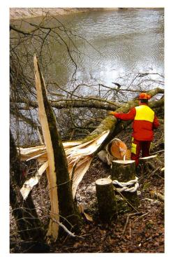
Bild 1. Diese Raubaumgruppe im Unterwasserkanal des Kraftwerks Rupperswil wird auch dem Hochwasser standhalten. Der geringe Mehraufwand für das Anbinden mit einem Sisalseil lohnt sich (Foto: H. Dorer)
