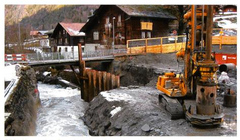
Bild 1. Vorgebohrte Spundwände als Baugrubenabschluss.
