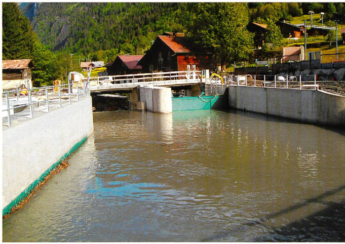
Bild 3. Neue Wehranlage von der OW-Seite; links ist der Grobrechen sichtbar.
