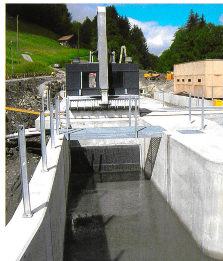
Bild 2. Entsander-Einlauf mit Feinrechen und Rechenreinigungsmaschine.
