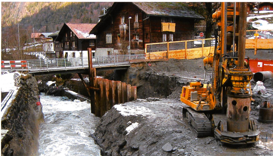
Bild 1. Vorgebohrte Spundwände als Baugrubenabschluss.
