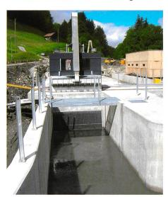
Bild 2. Entsander-Einlauf mit Feinrechen und Rechenreinigungsmaschine.
