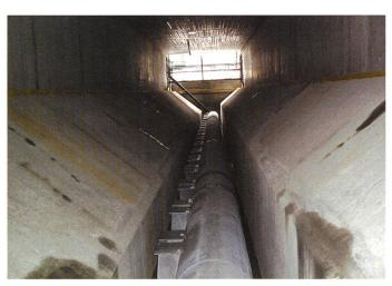
Bild 4. Sandabzugrohre mit Einlaufkästen.
