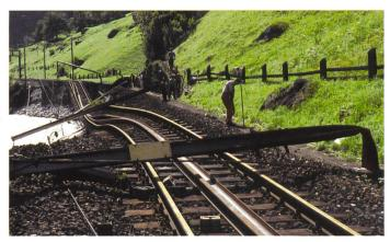
Bild 9. Der Schaden der Unwetter von 1987 betrug, verteilt auf drei Ereignisse, rund 1,3 Milliarden Franken. Im Bild, die unterspülte Gotthardbahnlinie bei Gurtnellen UR, Ende August 1987.
