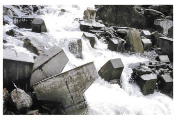
Bild 4. Blockrampe aus CABs im Charnawati River. Die Elemente sind durch die Strömung zusammengeschoben worden und haben sich untereinander verhakt. Zwischen den CABs abgelagertes Geschiebe verfestigt die Struktur zusätzlich.
