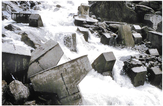
Bild 4. Blockrampe aus CABs im Charnawati River. Die Elemente sind durch die Strömung zusammengeschoben worden und haben sich untereinander verhakt. Zwischen den CABs abgelagertes Geschiebe verfestigt die Struktur zusätzlich.
