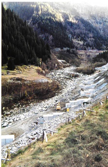
Bild 8. Bau der 10 aus Prismen bestehenden, deklinant angeordneten Bühnen auf der Höhe des Teufelssteins bei Göschenen (Blick flussaufwärts).
