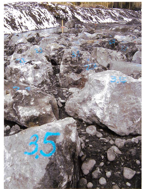
Bild 18. Bauüberwachung und Qualitätssicherung, angeschriebene Massen auf Einzelblöcken.
