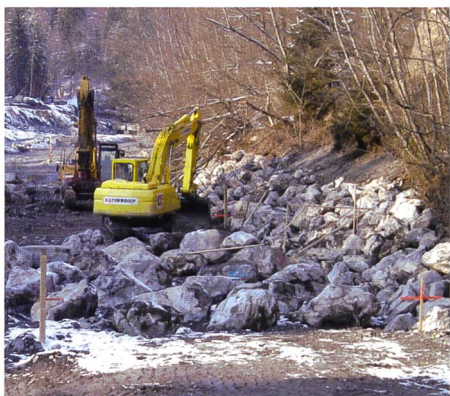
Bild 13. Erstellen Uferschutz im Vorlauf zum Versetzen der Einzelblöcke der Blockrampe.
