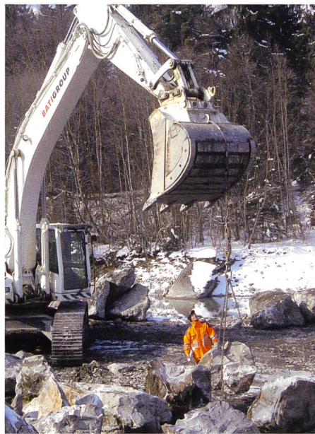
Bild 17. Bauüberwachung und Qualitätssicherung, Wiegen der Einzelblöcke.
