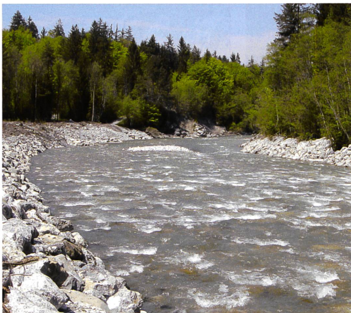
Bild 21. Blick flussaufwärts auf die fertige Blockrampe.
