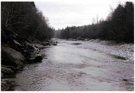
Bild 1. Kander vor Baubeginn 2004; begradigter, durch viele Buhnen eingeengter Flusslauf mit Breiten um die 32 m; Sohle eingetieft, Auendynamik weitgehend verschwunden.
