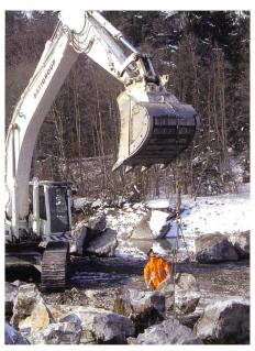
Bild 17. Bauüberwachung und Qualitätssicherung, Wiegen der Einzelblöcke.
