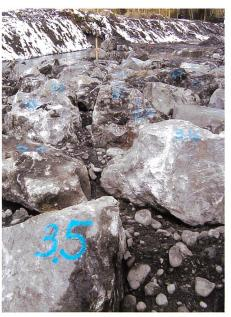
Bild 18. Bauüberwachung und Qualitätssicherung, angeschriebene Massen auf Einzelblöcken.
