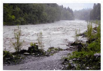
Bild 19. Abfluss von ca. 460 m<sup>3</sup>/s auf der Blockrampe am Vormittag des 22.8.05.
