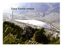
Déversements limités au bassin de rétention aménagé (ici en situation de vidange par la digue fusible rompue).
