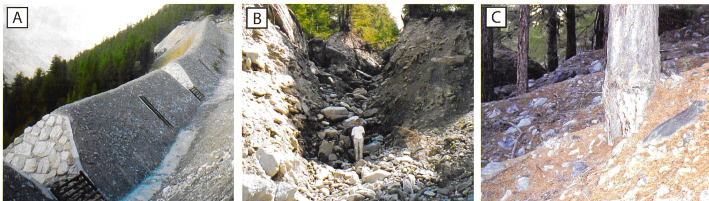
Bild 3. (A) Der unterste Damm mit den Durchlässen für die Murrinnen. (B) Die Rinnen Mitte und Süd fließen bei Kote 1650 zusammen und münden in ein Auffangbecken. (C) Murgangablagerungen unterhalb des untersten Damms weisen auf frühere Muraktivität der Rinne Nord in diesem Bereich hin.
