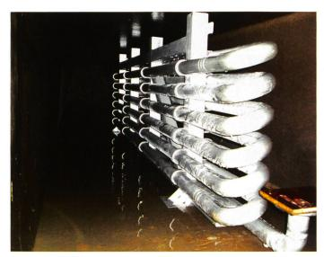
Bild 4. Neuer Wasser-/Wasserkühler, Eigenfertigung BKW.
