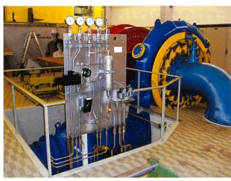
Bild 3. Neue hydraulische Kugelschieber-Steuerung, Eigenfertigung BKW.
