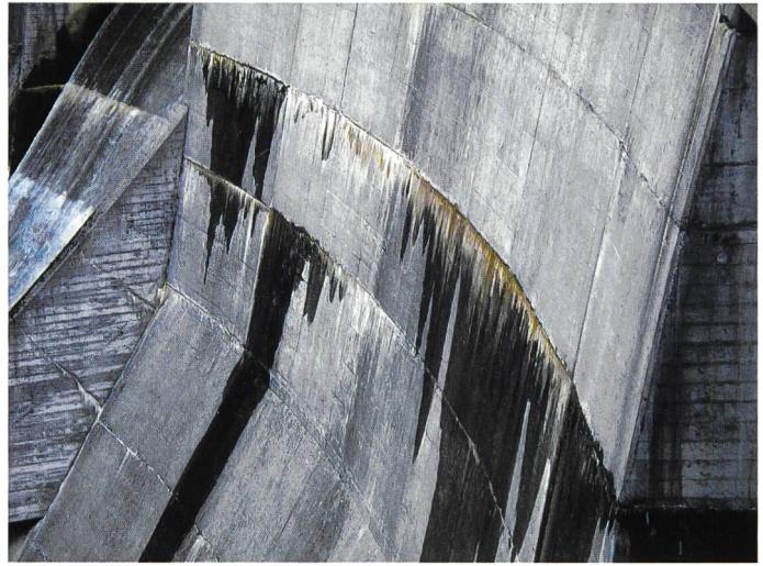
Bild 4. Wasseraustritt auf der Luftseite.
