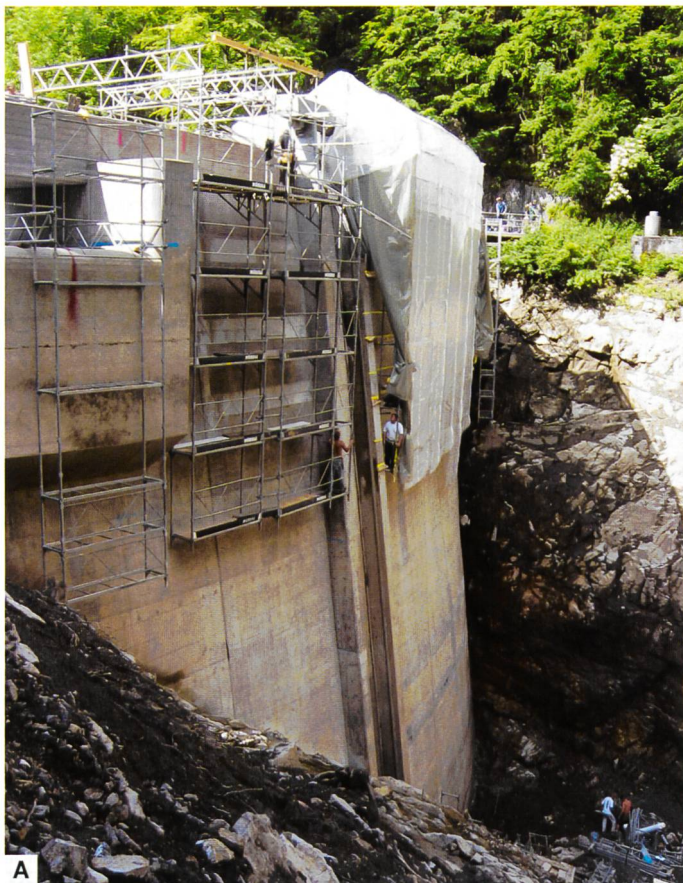
Bild 6. Während (links) und nach (rechts) erfolgter Riss-Sanierung.
