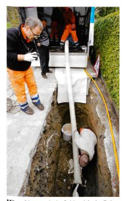
Mit ca. 2 bar wurde der Schlauch in das Rohr der EWS Energie AG in Reinach AG hinein-gepresst. Durch das Umstülpverfahren von Sanflex® wurde der Kleber an die Rohr-Innenwand gepresst. Die Druckluft diente nicht nur als Vortrieb, sondern übte gleichzeitig den erforderlichen Anpressdruck aus.
