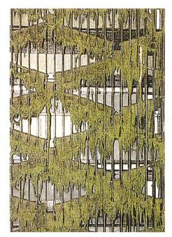
Bild 6. Starke Verlegung des Einlaufrechens mit Wasserpflanzen, die sich um die Quertraversen gelegt haben und sich dem Zugriff durch die automatische Rechenreinigung weitgehend entziehen.
