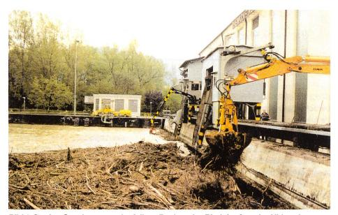
Bild 1. Starker Geschwemmselanfall am Rechen des Rheinkraftwerks Albbruck-Dogern beim Maihochwasser 1991. Innerhalb von zwei Tagen fielen insgesamt rund 4000 m<sup>3</sup> Geschwemmsel an, was dem Transportvolumen von ca. 500 Lastwagen entsprechen würde.
