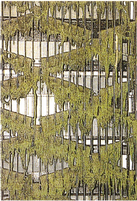
Bild 6. Starke Verlegung des Einlaufrechens mit Wasserpflanzen, die sich um die Quertraversen gelegt haben und sich dem Zugriff durch die automatische Rechenreinigung weitgehend entziehen.
