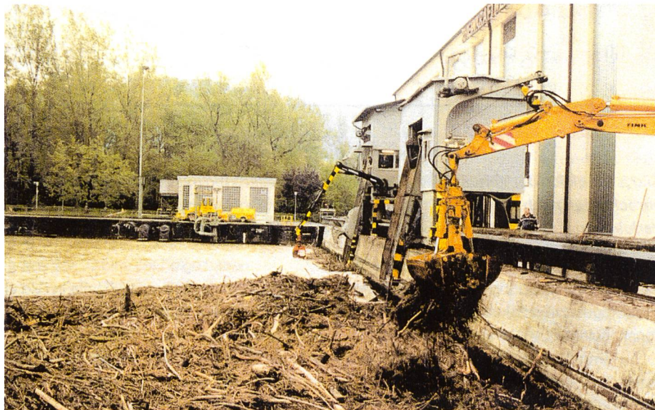
Bild 1. Starker Geschwemmselanfall am Rechen des Rheinkraftwerks Albbruck-Dogern beim Maihochwasser 1991. Innerhalb von zwei Tagen fielen insgesamt rund 4000 m 3 Geschwemm an, was dem Transportvolumen von ca. 500 Lastwagen entsprechen würde.
