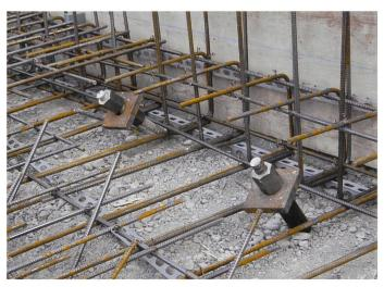
Bild 3. Teilweise fertig bewehrte Gehwegplatte mit bergseitigen, geneigten Mikropfählen. Die Kopfplatte wird aus Kraftschlussgründen einbetoniert.
