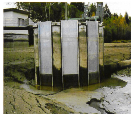
Bild 3. Sedimentablagerungen im See vor Fassungs-turm.
