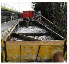
Bild 8. Absetzmulde für grobkörniges Material.
