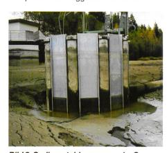
Bild 3. Sedimentablagerungen im See vor Fassungsturm.
