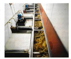
Bild 1. Transport der Holzschnitzel in die Feuerung.
