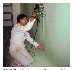
Bild 2. Das Verbinden der Bahnen erfolgt durch Heissluftschweissen mit speziellen Schweissautomaten oder Handföhn. Das Sarnafil-System ist vom Schweizerischer Verein des Gas- und Wasserfaches SVGW zertifiziert und zugelassen.
