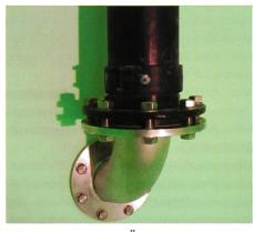
Bild 3. Anschluss an Überlaufrohr.
