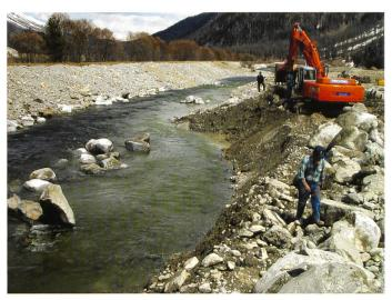
Bild 5. Der ökologische Baubegleiter ist am Bau mit weit reichenden Befugnissen ausgestattet. So gibt er der Bauleitung und dem Baggerführer konkrete Anweisungen zur Massnahmenumsetzung (links). Um alternative Möglichkeiten der Gerinnegestaltung und Strömungslenkung zu finden, veranlasst der Baubegleiter an Versuchsstrecken Tests mit unterschiedlichem Material und unterschiedlichen Uferverläufen (Fotos: Rey).
