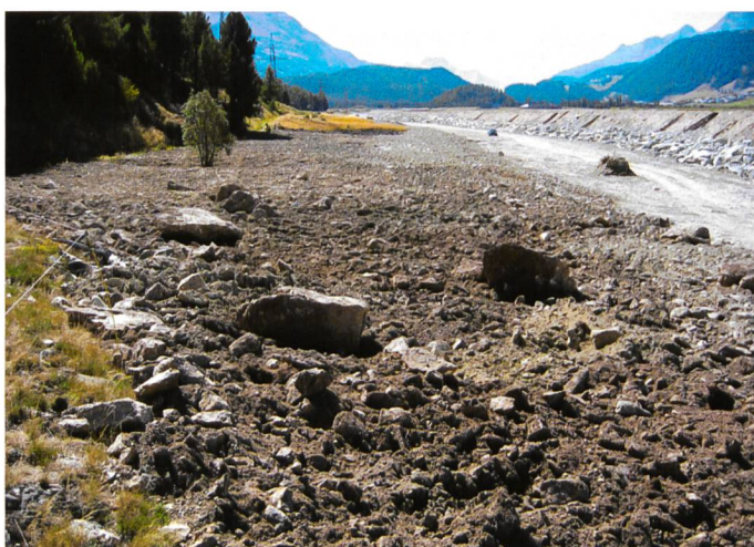
Bild 7. Eine harmonische Angleichung zwischen Gerinne und Geländeprofil erfolgte überall dort, wo der Entwicklungsplan den hierfür benötigten Raum offen liess. Links: restrukturierter Übergang vom neuen Flazgerinne (vor der Flutung) zum Hangfuss des Muottas Muragl. Rechts: An den Ufern des neu gestalteten Flaz vegl werden die alten Hochwasserdämme (Hintergrund) eingearbeitet und das Geländeniveau der Ufer an das des Umlandes angeglichen (vgl. auch Bild 2, unten) (Fotos: Pitsch/Rey).
