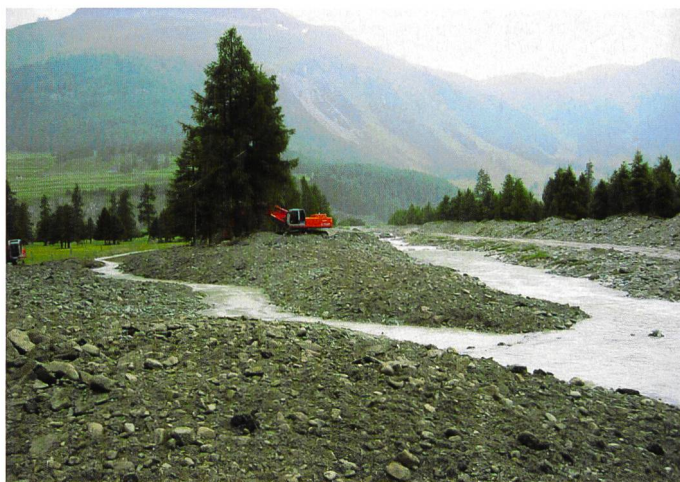
Bild 3. Für die Ausleitung des Inns in das Gerinne des alten Gravatschakanals und die Gestaltung des Flaz vegl standen ausreichende Räume zur Verfügung, um eine dynamische Eigenentwicklung von Fluss, Ufer und angrenzendem Umland/Aue zuzulassen. Ein späterer Gewässerunterhalt ist hier nicht mehr vorgesehen. Links: aufgeweitetes Gravatschagerinne im Herbst 2004 (noch ohne Innwasser); rechts: Furkation und Ableitungen im Flaz vegl Höhe Chachaluf (Fotos: Rey Pitsch).
