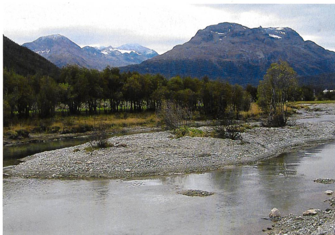
Bild 3. Für die Ausleitung des Inns in das Gerinne des alten Gravatschakanals und die Gestaltung des Flaz vegl standen ausreichende Räume zur Verfügung, um eine dynamische Eigenentwicklung von Fluss, Ufer und angrenzendem Umland/Aue zuzulassen. Ein späterer Gewässerunterhalt ist hier nicht mehr vorgesehen. Links: aufgeweitetes Gravatschagerinne im Herbst 2004 (noch ohne Innwasser); rechts: Furkation und Ableitungen im Flaz vegl Höhe Chachaluf (Fotos: Rey Pitsch).
