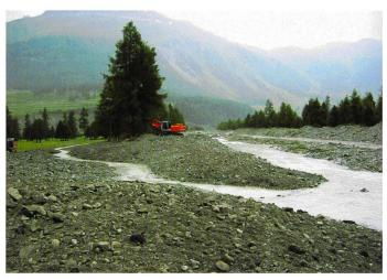
Bild 3. Für die Ausleitung des Inns in das Gerinne des alten Gravatschakanals und die Gestaltung des Flaz vegl standen ausreichende Räume zur Verfügung, um eine dynamische Eigenentwicklung von Fluss, Ufer und angrenzendem Umland/Aue zuzulassen. Ein späterer Gewässerunterhalt ist hier nicht mehr vorgesehen. Links: aufgeweitetes Gravatschagerinne im Herbst 2004 (noch ohne Innwasser); rechts: Furkation und Ableitungen im Flaz vegl Höhe Chachaluf (Fotos: Rey Pitsch).
