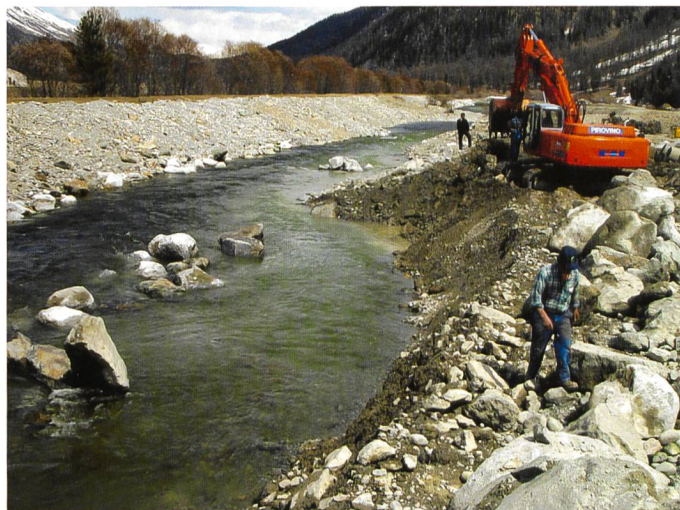
Bild 5. Der ökologische Baubegleiter ist am Bau mit weit reichenden Befugnissen ausgestattet. So gibt er der Bauleitung und dem Baggerführer konkrete Anweisungen zur Massnahmenumsetzung (links). Um alternative Möglichkeiten der Gerinnegestaltung und Strömungslenkung zu finden, veranlasst der Baubegleiter an Versuchsstrecken Tests mit unterschiedlichem Material und unterschiedlichen Uferverläufen (Fotos: Rey).
