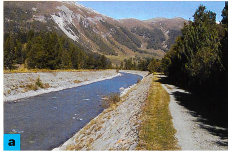
Bilder 8 a, b. Rückbau des kanalisierten Flazgerinnes (links), rückgebauter Flazkanal (rechts).
