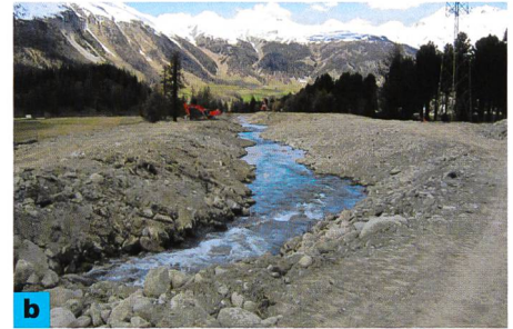
Bilder 8 a, b. Rückbau des kanalisierten Flazgerinnes (links), rückgebauter Flazkanal (rechts).
