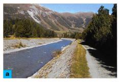
Bilder 8 a, b. Rückbau des kanalisierten Flazgerinnes (links), rückgebauter Flazkanal (rechts).
