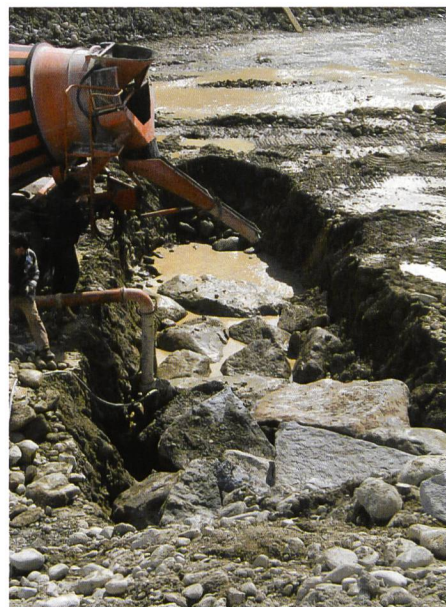
Bild 2. Bau des Querriegels am Anfang der Steilstrecke.
