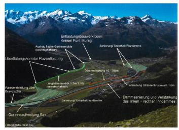
Bild 6. Flazentlastung – Fotomontage der Flazentlastung für den Hochwasserfall  $HQ_{100}$  mit einer Abflussmenge im Überflutungskorridor von ca. 120 m<sup>3</sup>/s.
