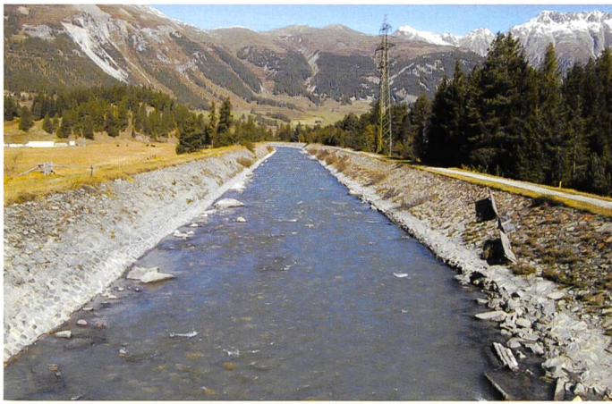
Bild 2. Vom Kanal (Flazkanal im Bereich Golfplatz) zum naturnah ausgebildeten Wasserlauf (neuer Flazlauf) (Bild links: E. Toscano AG, Bild rechts: VAW/Hydra).
