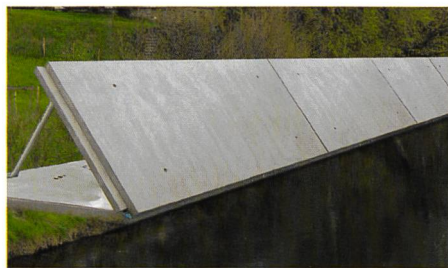
Bild 1. Der multifunktionale, kostengünstige Dammersatz lässt sich normalerweise als Gehweg nutzen. Bei Hochwassergefahr lassen sich die Schutzwände innert weniger Minuten automatisch aufrichten.
