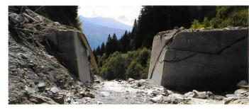
Bild 8. Zerstörte Brücke in Schluein (Bildquelle: B. McArdell, WSL).
