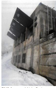
Bild 2. Aussenansicht des Bunkers, wo die Lawinenmessungen gemacht werden. Die Luken werden jeweils vor dem Eintreffen der Lawine geschlossen.
