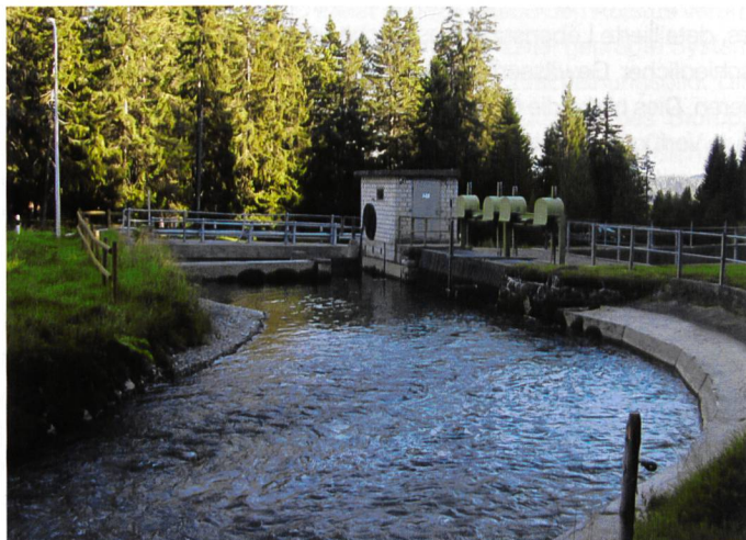
Bild 2. Wasserfassung.
