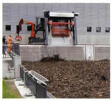
Bild 2. Überforderte Rechenreinigungsmaschine.
