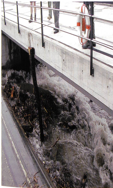
Bild 5. Verklausung bei Segment.
