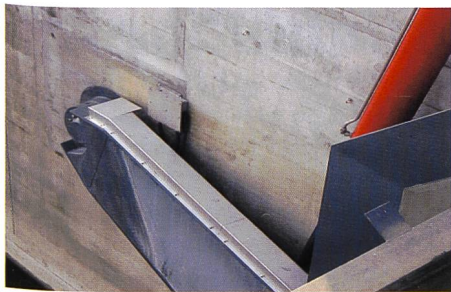
Bild 4. Verkabelung für Seitenschildheizung und Verschlauchung für Aufsatzklappenzylinder.
