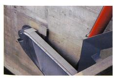
Bild 4. Verkabelung für Seitenschildheizung und Verschlauchung für Aufsatzklappenzylinder.
