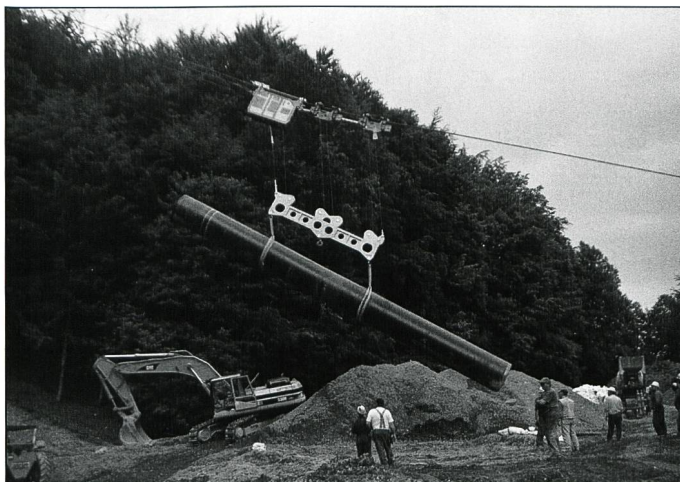
Transport und Versetzen Erdgasleitung, Rohrgewicht 12 Tonnen
