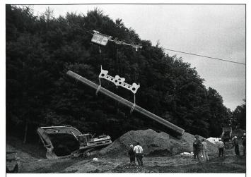
Transport und Versetzen Erdgasleitung, Rohrgewicht 12 Tonnen
