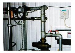
Mit einer Messdynamik von 1:800 sind sowohl Spitzenwerte als auch die Leckagemengen mit ein und demselben Sensor zuverlässig messbar. Die Einsteck-Bauweise ermöglicht den Einbau in jede Rohrleitung, die DN 25 beziehungsweise R 1" oder arösser ist.
