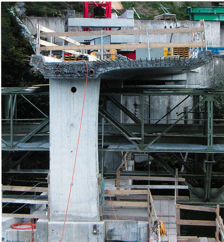
Bild 7. Fertiger Brückenquerschnitt über dem Schiffsaufzug.
