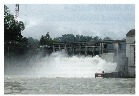
Bild 2. Das alte Wehr bei Q = ca. 460  $m^3/s$ , Brücke über Schiffsaufzug (links) bereits abgebrochen, breitere Öffnungen rechts = «KKM-Klappen».
