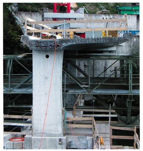
Bild 7. Fertiger Brückenquerschnitt über dem Schiffsaufzug.
