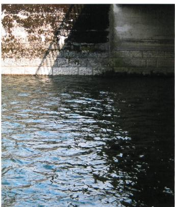
Bild 4. Die Glatt beim Pegel Rümlang am 26. Oktober 2000 bei einem Abfluss von 5 m³/s (links) und am 16. April 2002 bei einem Abfluss von 4 m³/s (rechts). Die starke Verkrautung zu diesem Zeitpunkt bewirkte eine Erhöhung des Wasserspiegels um einen halben Meter, sodass der Überfall verschwindet.
