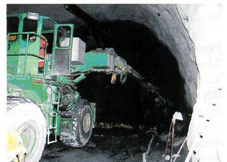
Bild 8. Bohrwagen beim Herstellen der Sprengbohrlöcher (Quelle: IGWS).
