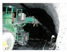
Bild 8. Bohrwagen beim Herstellen der Sprengbohrlöcher (Quelle: IGWS).
