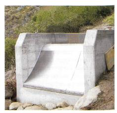
Bild 2. Fassungsschacht samt Rechen unmittelbar nach der Fertigstellung.
