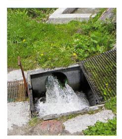
Bild 1. Der alte Einlaufschacht mit vertikalem Gitterrost.
