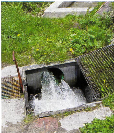
Bild 1. Der alte Einlaufschacht mit vertikalem Gitterrost.
