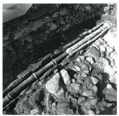
Bild 4.1990 ausgegrabenes Teilstück der kurz nach 1230 erstellten tönernen Züblileitung des Predigerklosters in Zürich; der Einbettungsmörtel wurde entfernt (Foto: Baugeschichtliches Archiv der Stadt Zürich).
