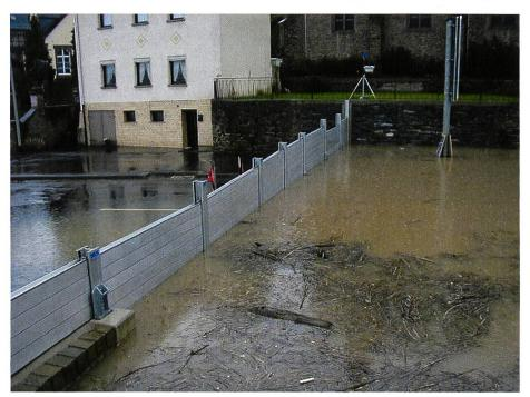
Bild 4. Mobile Hochwasserabsperrung einer Strasse mit Dammbalken.
