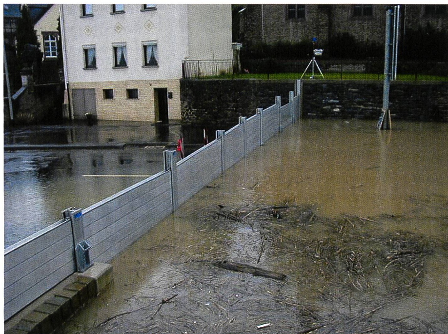
Bild 4. Mobile Hochwasserabsperreinrichtung einer Strasse mit Dammbalken.
