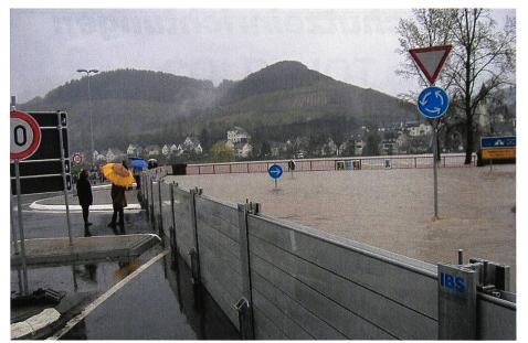
Bild 3. Dammbalken im Einsatz während eines Hochwassers in Alf an der Mosel.
