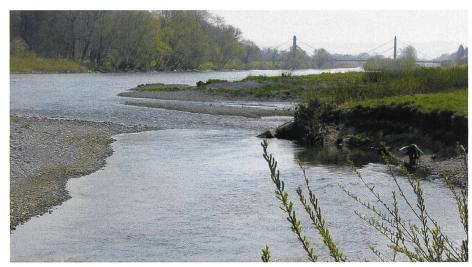
Bild 9. Ufererosion in leicht erodierbaren Feinsedimentablagerungen und Sicherung mit Buhnen. Aufweitung der Thur bei Altikon (Kanton Zürich).
