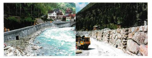
Bild 1. Ufermauern mit Rauigkeitsrippen in Gurtnellen an der Reuss (links) und in Saas Almagell an der Vispa (rechts).
