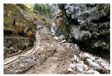
Bild 1. Bau der Blockrampe 1987; Baupiste und eingeengtes Gerinne, Blick gegen die Fliessrichtung (Foto: J.-P. Zuppiger).
