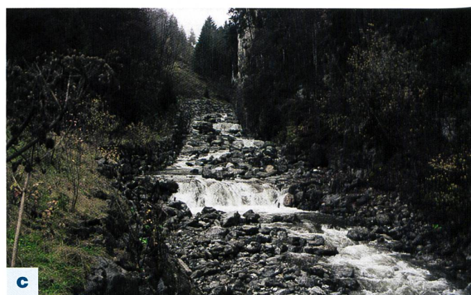
Bild 4. Hochwasserereignis vom Mai 1999; a) bordvoller Abfluss, Blick gegen die Fliessrichtung; b) Schäden im Bereich der Linkskurve, Blick in Fliessrichtung; c) Übersicht über die Schäden im unteren Rampenteil, Blick von der Gegenschwelle gegen die Fliessrichtung.
