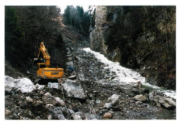
Bild 2. Blockrampe und rechtsufrige Mauer im verbreiterten unteren Teil im Jahr 1989, Blick von der Gegenschwelle flussaufwärts (Foto: J.-P. Zuppiger).
