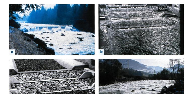
Bild 1. a) Sanierungsbedürftige Absturzbauwerke in der Kander 1973; b) damaliger Lösungsvorschlag mit Sperrentreppen im Modell; c) im Modell 1973 untersuchte Blockrampe; d) kürzlich erbaute Rampe bei Mülenen.
