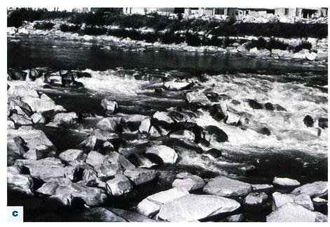
Bild 2. Schwelle bei Lodrino am Ticino: a) beschädigte Rampe, ca. 1983; b) aufgrund von Modellversuchen neu gebaute massive Rampe, ca. 1986; c) im Hochwasser von Juli 1987 teilweise beschädigte Rampe.
