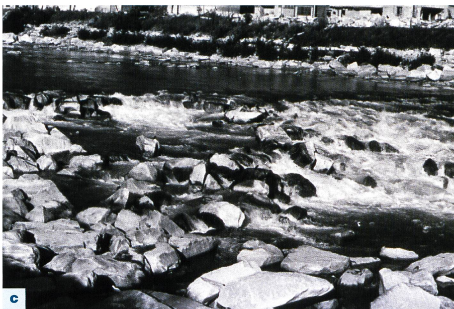
Bild 2. Schwelle bei Lodrino am Ticino: a) beschädigte Rampe, ca. 1983; b) aufgrund von Modellversuchen neu gebaute massive Rampe, ca. 1986; c) im Hochwasser von Juli 1987 teilweise beschädigte Rampe.
