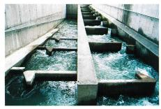
Bild 4. Unterer Abschnitt des Schlitzpasses.
