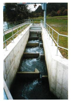
Bild 9. Oberer Abschnitt des Schlitzpasses mit Kontrollreuse.
