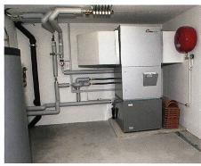
Bild 2. Die Luft-Wasser-Wärmepumpe und die 4,5 m² grosse Solaranlage versorgen das Haus mit der notwendigen Energie (Foto: Informationsstelle Bern).
