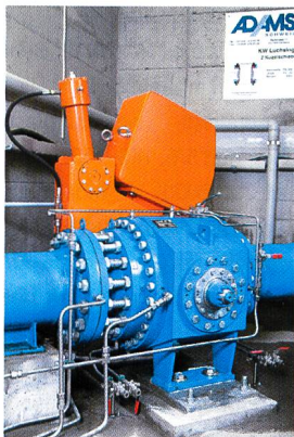
Rohrbruchsicherung Sicurezza rottura tubo Sécurité rupture de tuyau
