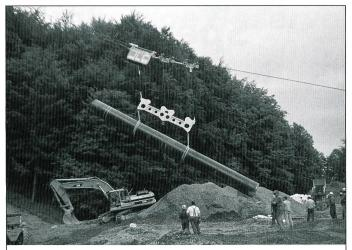
Transport und Versetzen Erdgasleitung, Rohrgewicht 12 Tonnen
