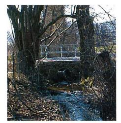
Bild 3. Starke Querschnittsverengung durch einen Durchlass.
