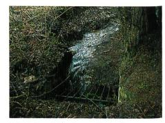
Bild 8. Durch Rechen vollständig abgedeckter Einlauf zu einer Eindolung, Versagenswahrscheinlichkeit sehr hoch.
