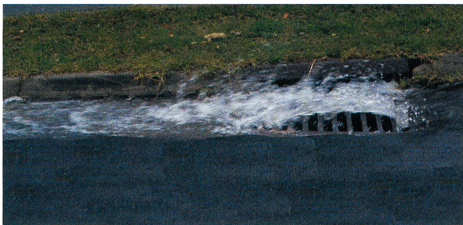
Bild 10. Auf steilen Strassen werden Kanalisationseinläufe oft überschossen, sofern die Fliessgeschwindigkeit entsprechend hoch ist.
