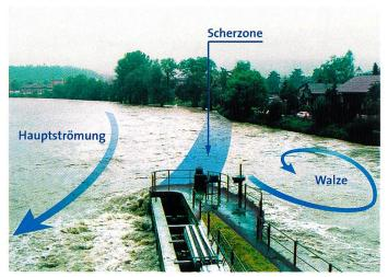
Bild 12. Abflusssituation an Pfingsten 1999, freier Wehrdurchfluss von 520 m<sup>3</sup>/s. Links: Blick in Strömungsrichtung. In Bildmitte ist die Scherzone schwach zu erkennen. Rechts: Blick flussaufwärts. Aufgrund der starken Wirbelbildung wirken grosse hydromechanische Belastungen auf den Untergrund ein (Bildquelle: Edy Toscano AG).
