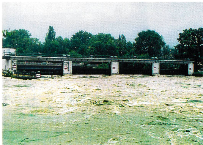
Bild 12. Abflusssituation an Pfingsten 1999, freier Wehrdurchfluss von 520 m 3 /s. Links: Blick in Strömungsrichtung. In Bildmitte ist die Scherzone schwach zu erkennen. Rechts: Blick flussaufwärts. Aufgrund der starken Wirbelbildung wirken grosse hydromechanische Belastungen auf den Untergrund ein (Bildquelle: Edy Toscano AG).
