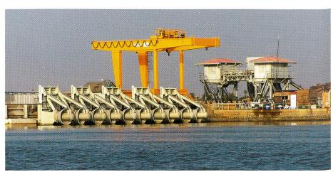
Bild 1. Fünf Hydromatrix®-Turbinenmodule und Dammkran des Kraftwerks Jebel Aulia.
