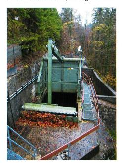
Bild 2. Neue Rechenreinigungsmaschine im Wasserschloss.
