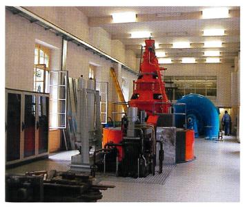
Bild 3. Revidierte Turbinen-Generatorgruppe Nr. 2, im Vordergrund der umgebaute Turbinenregler, links die neuen Maschinenleittechnik-Schränke.
