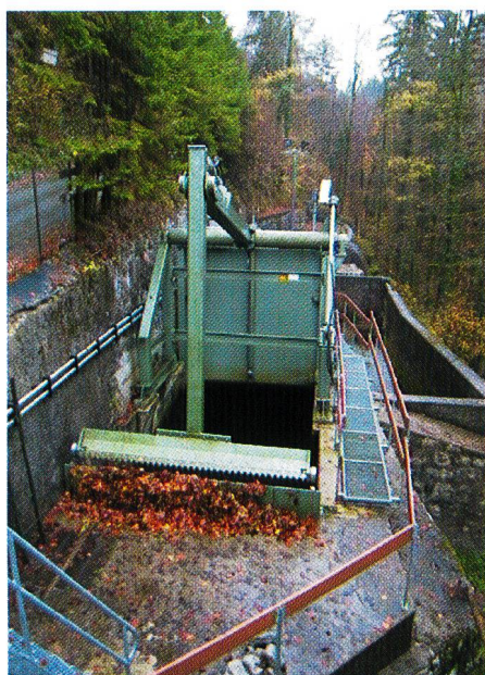
Bild 2. Neue Rechenreinigungsmaschine im Wasserschloss.
