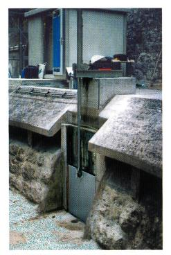
Bild 1. Dotierschütze im Wasserschloss, im Hintergrund das neue Betriebsgebäude.
