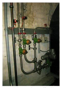
Bild 8. Kühlwasseranlage von Maschine Nr. 2, umgebaut für Automatikbetrieb.
