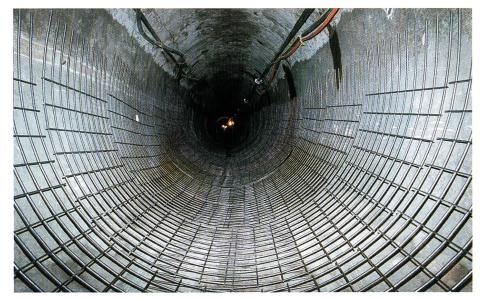
Bild 7. Armierung der Stollenverstärkung in der Lockermaterialstrecke.
