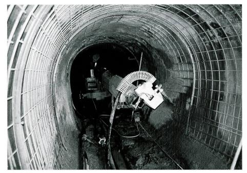
Bild 9. Einsatz von Spritzrobotern im Stollengewölbe.
