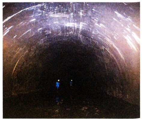
Bild 5. Reservoirkammer des Wasserschlosses.
