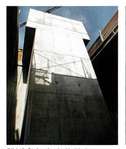
Bild 13. Steigschacht, Verbindung Kanal/Holzdruckleitung.
