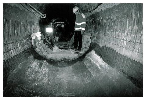
Bild 8. Betonierung des Sohlbereichs mit Gleitschalung.
