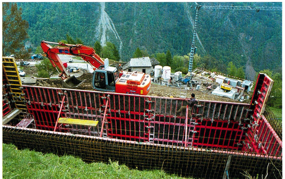
Bild 11. Bau der oberen Wasserschlosskammer.
