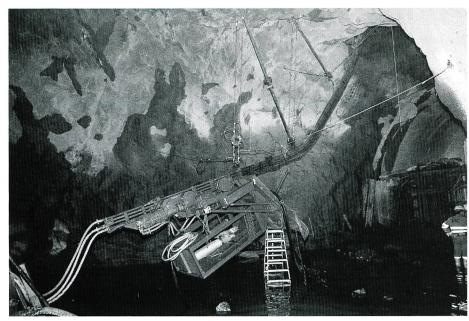
Bild 16. Belüftungsschacht für die unteren Wasserschlosskammern.
