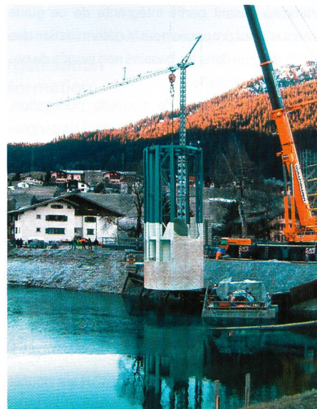
Bild 1. Der neue Turm wird ins Seebecken gehoben (Bild: RE).
