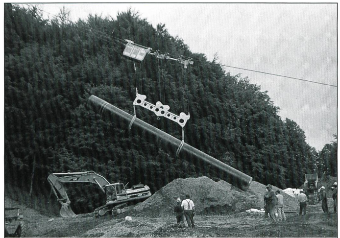
Transport und Versetzen Erdgasleitung, Rohrgewicht 12 Tonnen
