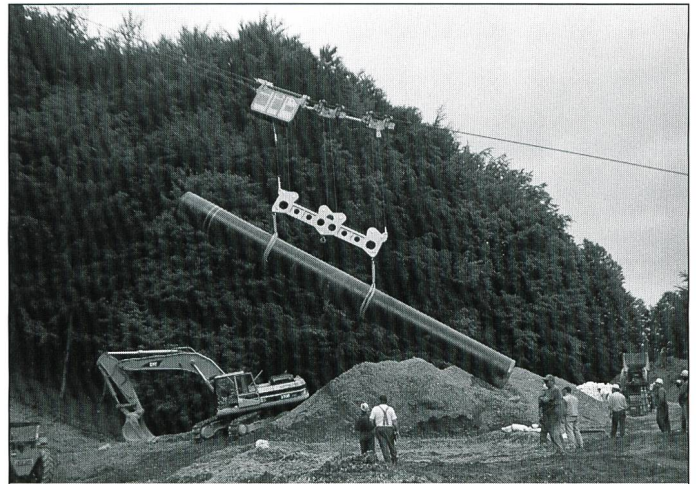
Transport und Versetzen Erdgasleitung, Rohrgewicht 12 Tonnen
