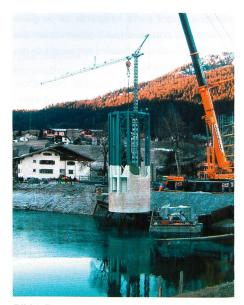
Bild 1. Der neue Turm wird ins Seebecken gehoben (Bild: RE).
