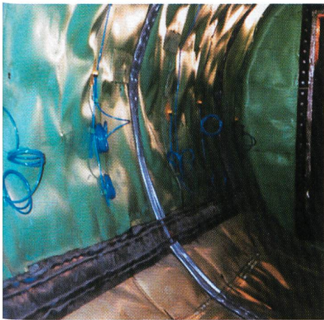
Bild 1. Noch während der Meeresboden gefroren ist, bekommen die Querstellen (Fluchtwege) im Westerscheldetunnel eine wasser-dichte Auskleidung aus FPO-Folie, die punktförmig am Untergrund befestigt wird (Foto: PeinigerRöRo).
