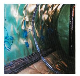
Bild 1. Noch während der Meeresboden gefroren ist, bekommen die Querstollen (Fluchtwege) im Westerscheldetunnel eine wasserdichte Auskleidung aus FPO-Folie, die punktförmig am Untergrund befestigt wird (Foto: PeinigerRöRo).
