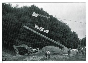
Transport und Versetzen Erdgasleitung, Rohrgewicht 12 Tonnen
