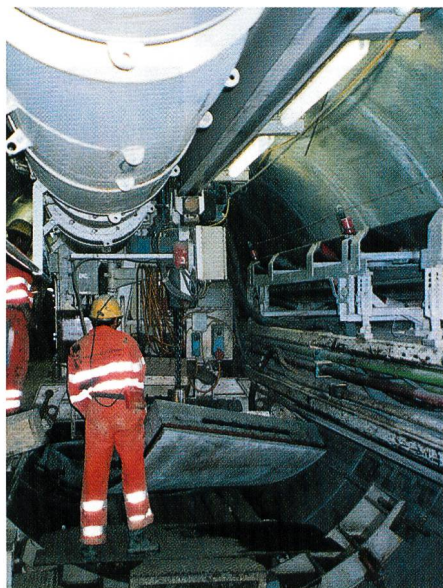
Bild 3. Einbau der Stahlfaserbeton-Tübbinge für den einschaligen Ausbau des 5,2 km langen Transitgasstollens Sörenberg.
