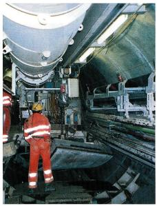
Bild 3. Einbau der Stahlfaserbeton-Tübbinge für den einschaligen Ausbau des 5,2km langen Transitgasstollens Sörenberg.
