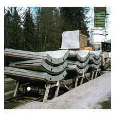
Bild 2. Zwischenlager für Stahlfaserbeton-Tübbinge.
