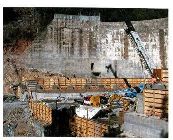
Bild 6. Erdbebenverstärkung der Weber-Gewölbemauer. Verstärkung der Widerlagerpfeiler durch RCC-Block, links: Endzustand, rechts: Bauzustand (Fotos: D. Babbitt).
