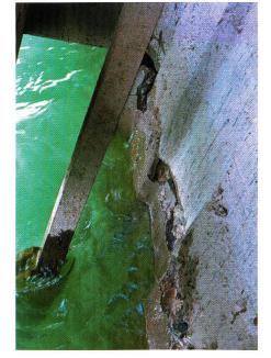
Bild 4. Horizontalrisse entlang den Arbeitsfugen im oberen Bereich der Sefid-Rud-Pfeilerkopfmauer, die 1990 während des Magnitude-7,7-Manjil-Erdbebens im Nordwesten Irans entstanden. Die Risse wurden mit Epoxymörtel ausinjiziert, und durch Vertikalvorspannung wurde die Scherfestigkeit verbessert.
