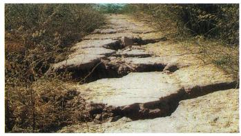
Bild 2. Erdbebenschäden an zwei Schüttdämmen (links: Shivlakha-Damm mit wasserseitiger Rutschung, rechts: massive Querrisse und Setzungen im Chang-Damm), die während des Bhuj-Erdbebens vom 26. Januar 2001 in Indien beschädigt wurden. Insgesamt mussten bei rund 245 Dämmen Reparatur- und Verstärkungsmassnahmen getroffen werden (Fotos: Prof. S. K. Jain und M. S. Patel).
