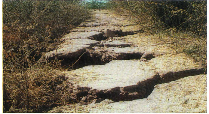
Bild 2. Erdbebenschäden an zwei Schütttdämmen (links: Shivilakha-Damm mit wasserseitiger Rutschung, rechts: massive Querrisse und Setzungen im Chang-Damm), die während des Bhuj-Erdbebens vom 26. Januar 2001 in Indien beschädigt wurden. Insgesamt mussten bei rund 245 Dämmen Reparatur- und Verstärkungsmassnahmen getroffen werden (Fotos: Prof. S. K. Jain und M. S. Patel).
