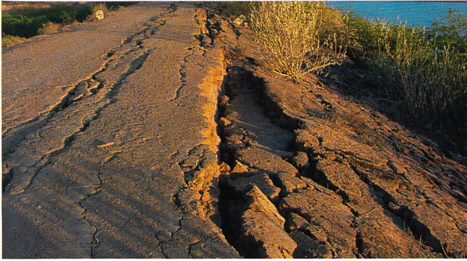
Bild 2. Erdbebenschäden an zwei Schütttdämmen (links: Shivilakha-Damm mit wasserseitiger Rutschung, rechts: massive Querrisse und Setzungen im Chang-Damm), die während des Bhuj-Erdbebens vom 26. Januar 2001 in Indien beschädigt wurden. Insgesamt mussten bei rund 245 Dämmen Reparatur- und Verstärkungsmassnahmen getroffen werden (Fotos: Prof. S. K. Jain und M. S. Patel).
