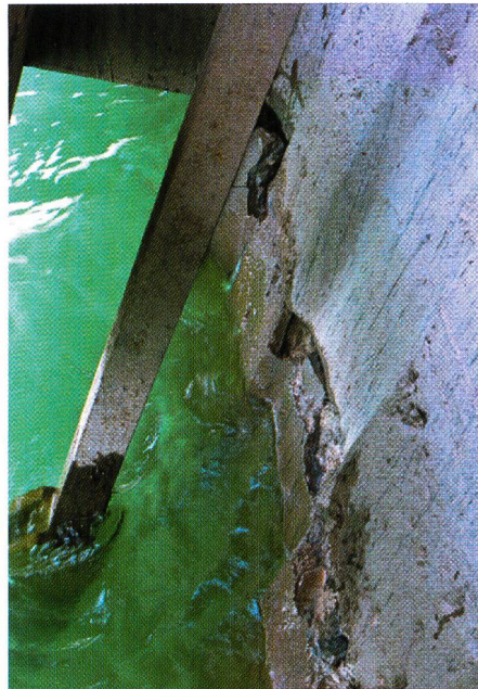
Bild 4. Horizontalrisse entlang den Arbeitsfugen im oberen Bereich der Sefid-Rud-Pfeilerkopfmauer, die 1990 während des Magnitude-7,7-Manjil-Erdbebens im Nordwesten Irans entstanden. Die Risse wurden mit Epoxymörtel ausinjiziert, und durch Vertikalvorspannung wurde die Scherfestigkeit verbessert.
